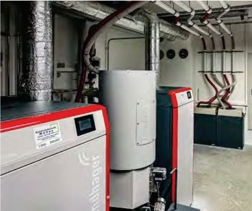
Die Beschickung der Kessel erfolgt über das Windhager-eigene Saugzugfördersystem mit 2 x 8 Entnahmesonden.
